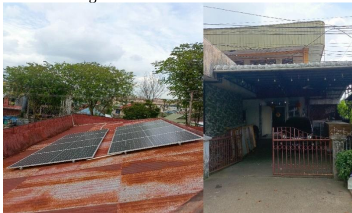
Gambar 1 Lokasi panel terpasang
