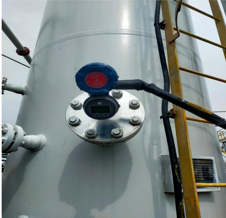
Gambar 2. level transmitter setelah diaplikasikan ke vessel kontaktor
