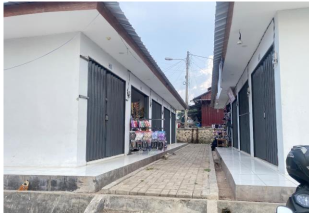
Gambar 1 Kondisi Kios Pedagang di Pasar Kepandean Pasca Relokasi Sumber: Peneliti, 2026
