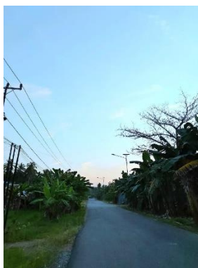
Gambar 1 Kondisi Ruas Jalan
