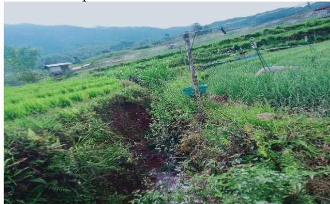
Gambar 3. kondisi eksisting saluran TA-1 (Sumber: Dokumentasi penelitian, 2025)
