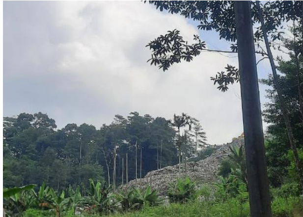
Gambar 4. Kondisi longsor TPA Sampah
