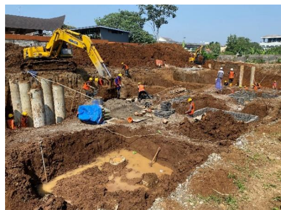
Gambar 4. Pekerjaan Fondasi, berpotensi menimbulkan dampak lingkungan Sumber : Dokumentasi Proyek SIG Tower 2025
