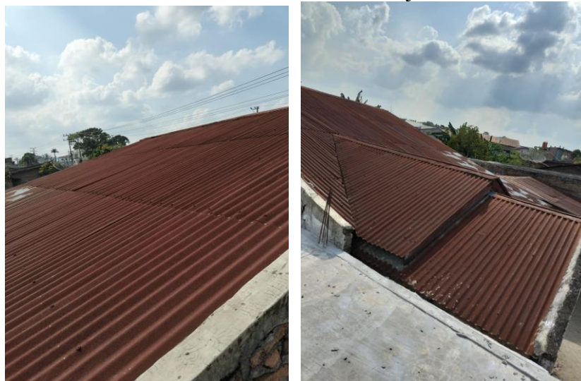
Gambar 2. Dokumentasi Atap Rumah
