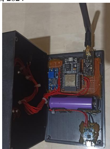
Gambar 3. Tampak Depan Hasil Sistem Monitoring Sollar Cell Sumber: Dokumentasi Penulis, 2024
