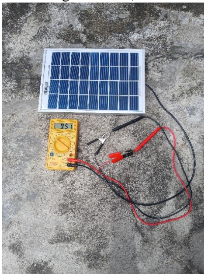
Gambar 12. Pengukuran Tegangan Sollar Cell Tanpa Beban
