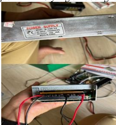
Gambar 1 Menghubungkan kabel positif dan negatif ke power supply
