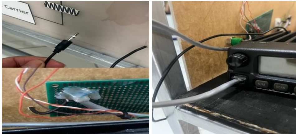
Gambar 3 Kabel Converter Sumber: Dokumentasi Pribadi, 2024
