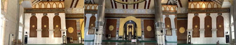
Gambar 6. Dinding interior sisi barat Sumber: (Penulis, 2026)
