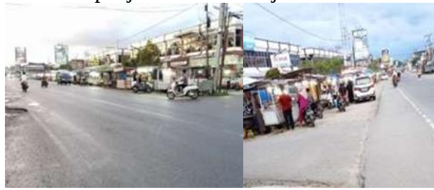
Gambar 7 Kondisi Eksisting Jalan Medan - Banda Aceh
